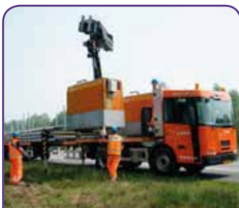
Plaatsing met behulp van smalle vrachtwagen (2VI) 1,10 mtr vrije ruimte
