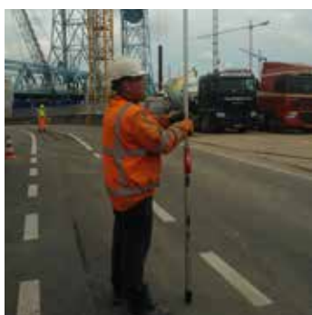
De doorrijhoogte wordt nauwkeurig bepaald en door middel van foto's vastgelegd.
